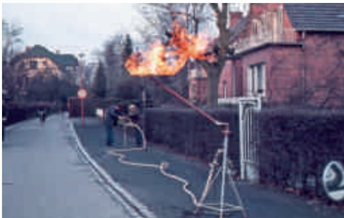
Bevor das Erdgas durch die Leitungen strömt, wird wie hier im Südwall das alte Stadtgas abgefackelt.
